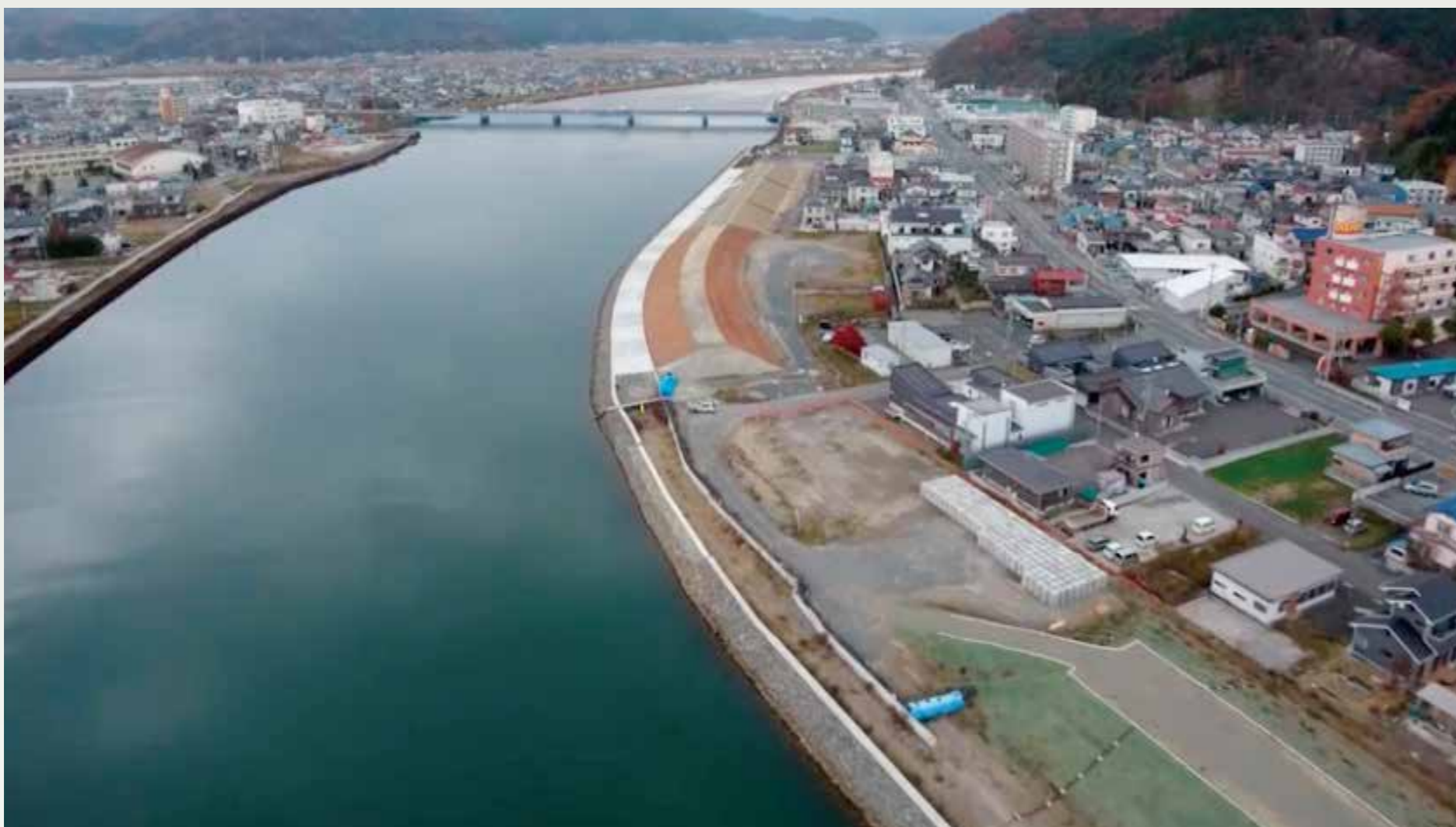
整備状況 [平成 30 年 11 月 ドローン撮影]
