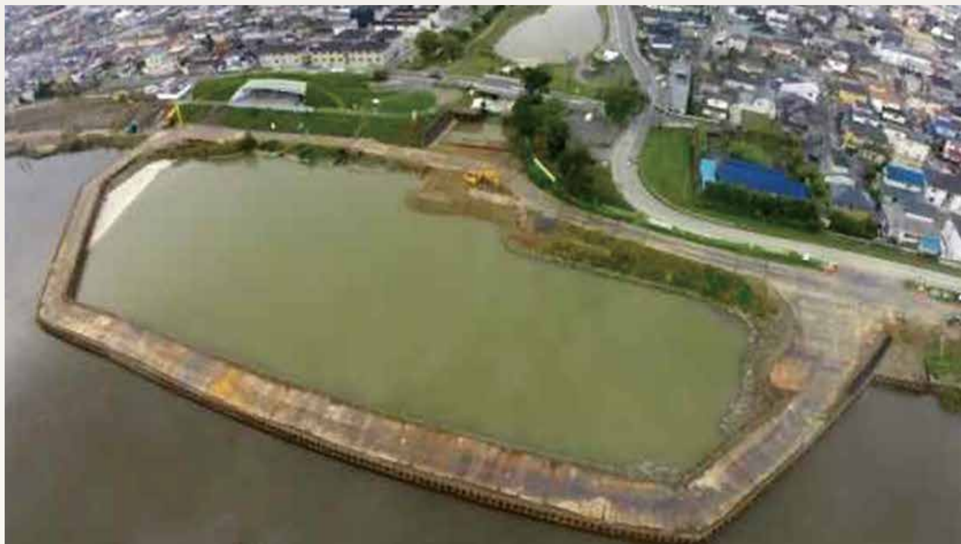
二重締切の設置 [平成 28 年 9 月 撮影]
