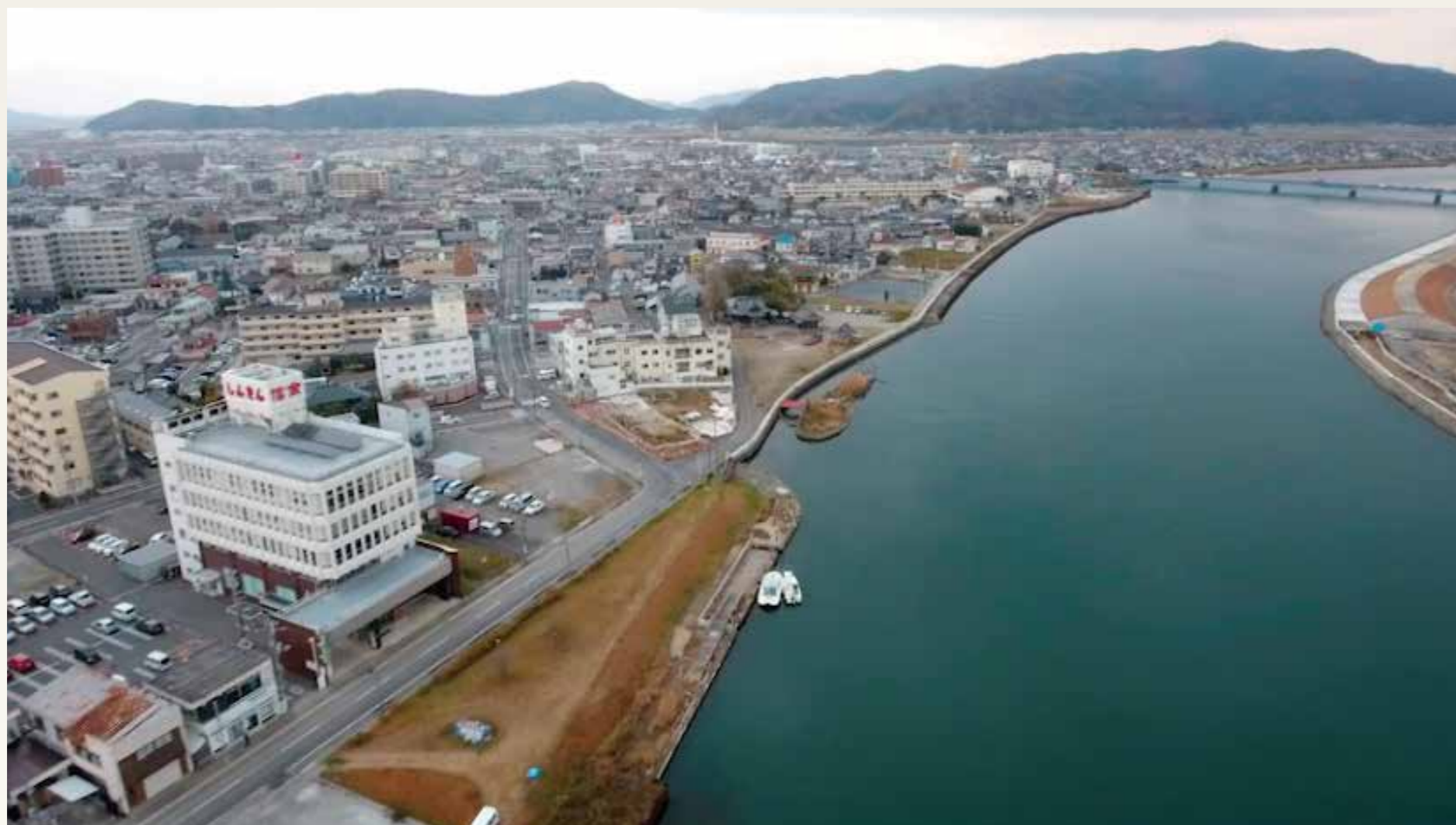
整備状況 [平成 30 年 11 月 ドローン撮影]
