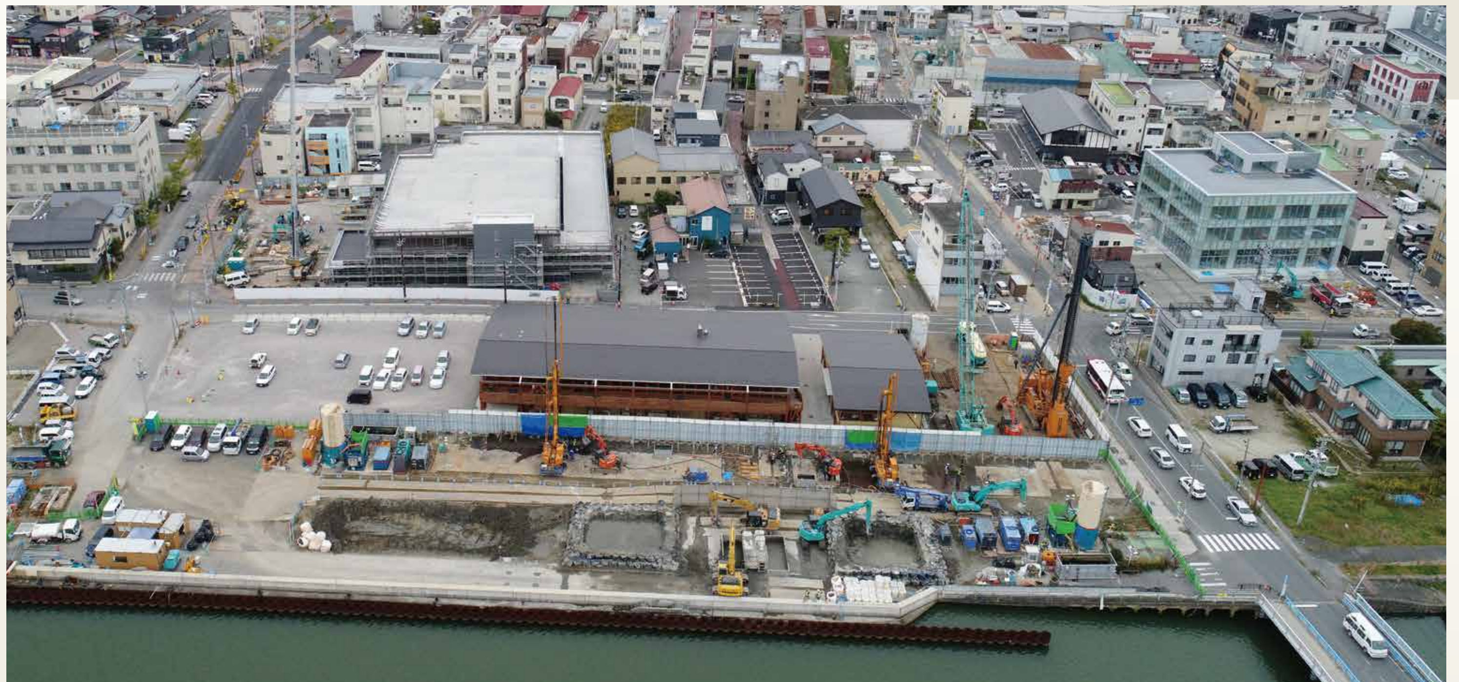
地盤改良の施工中 平成 29 年 10 月
