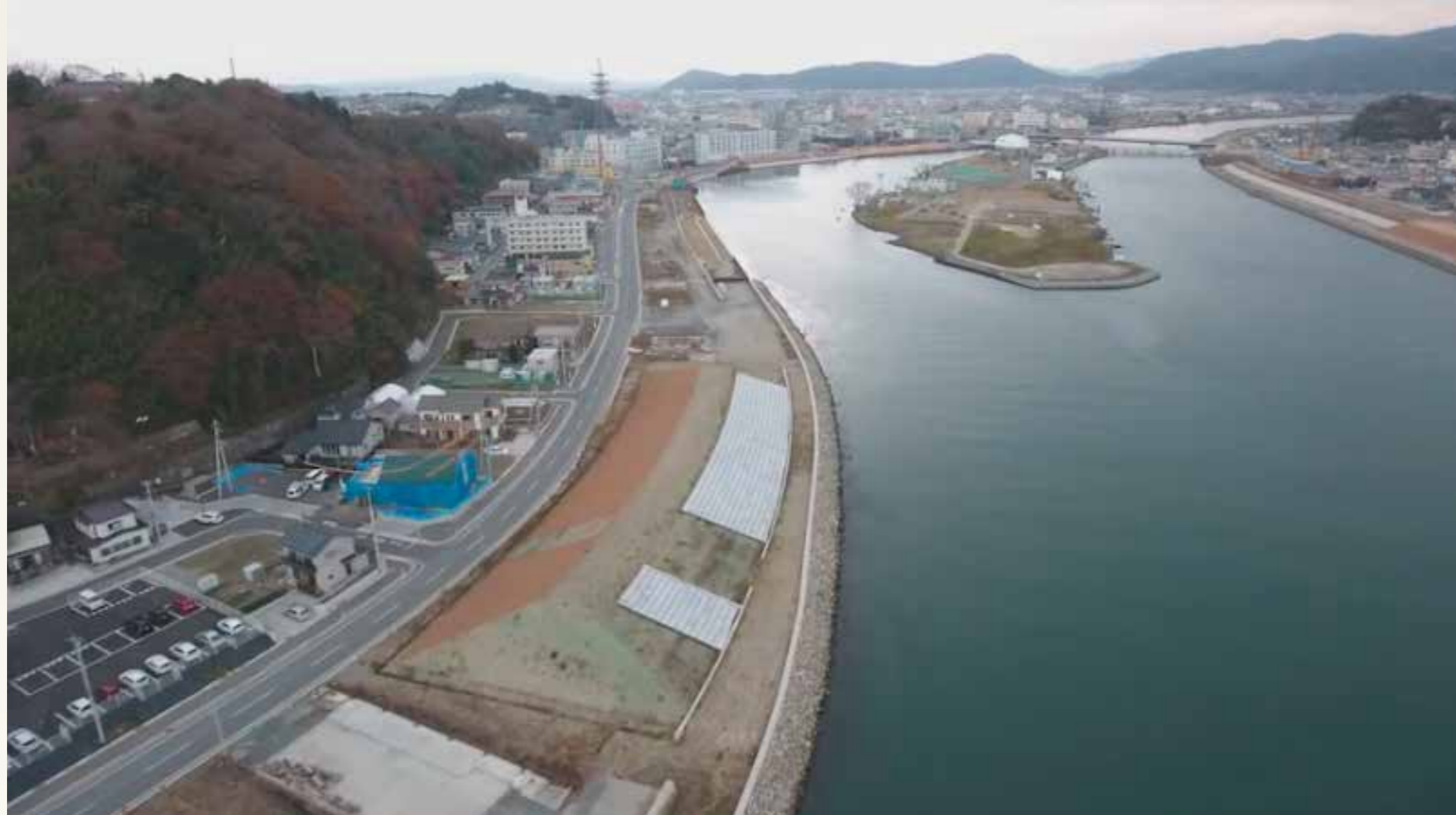
整備状況 [平成 30 年 11 月ドローン撮影]
