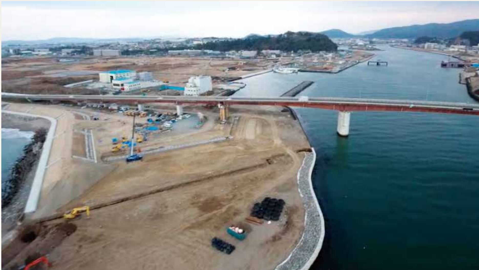
整備状況 [平成 30 年 11 月ドローン撮影]
