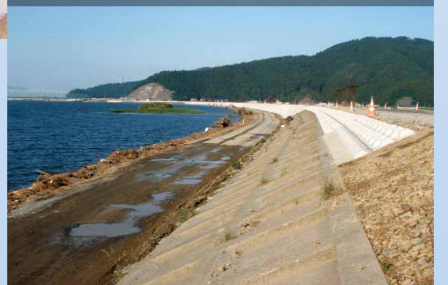
緊急復旧工事完了 平成 23 年 6 月 11 日
