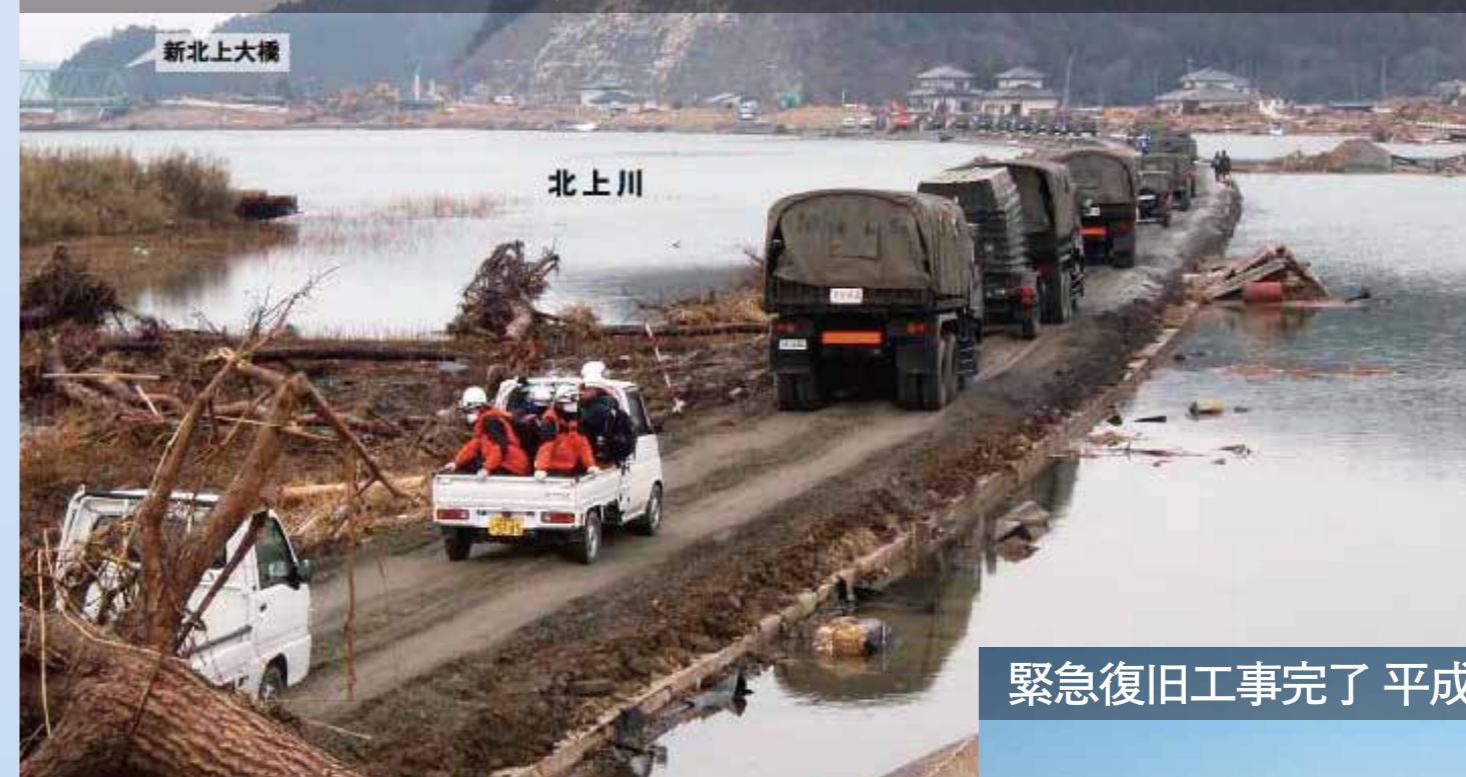
北上川河口部の河川堤防、暫定 1 車線で供用 平成 23 年 3 月 14 日
