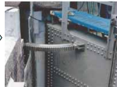
船頭平閘門 (M35) 手動円弧ギア型
