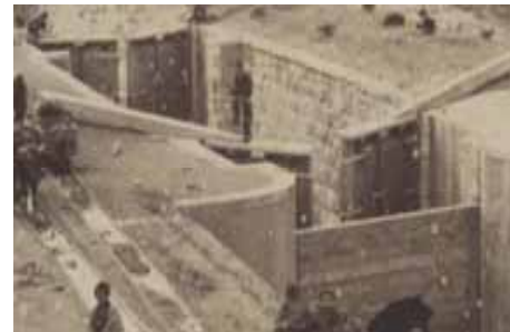
大津閘門 (M22) 手動開閉桿型
