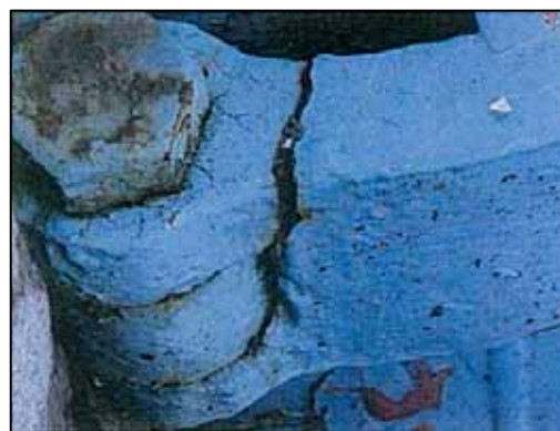
写真 門扉閘尾部基礎材(軸受け)の状況
