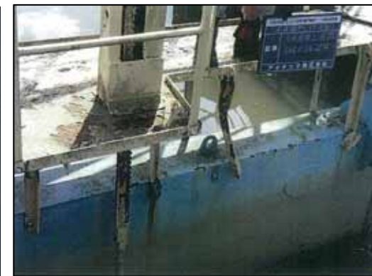
写真 門扉閘尾部管理橋の状況
