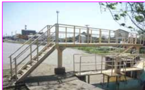
昭和41年に増設した管理橋
