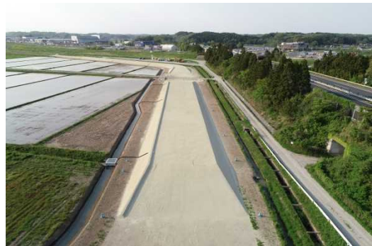
⑤吉田川上流改良築堤外工事(工期:H30.09.12~R1.05.31) 一期工事が完成しました。
