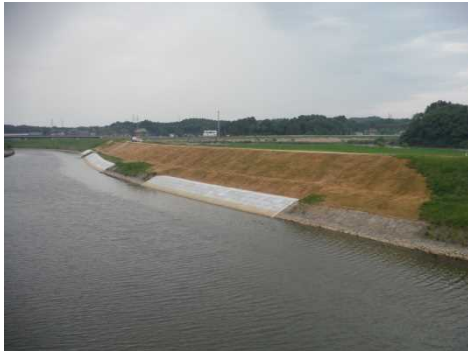
③吉田川宿浦地区災害復旧工事(工期:H30.09.06~R1.06.10) 新しい護岸が完成しました。
