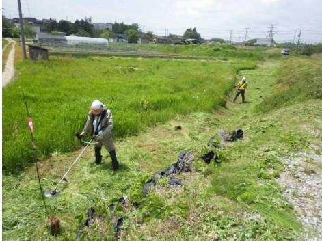
①鳴瀬川鳴瀬管内上流維持工事(工期:H31.4.1~R2.3.31) 1回目の除草作業を行っています。
