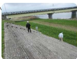
鳴瀬大橋 そば の木製階段護岸
