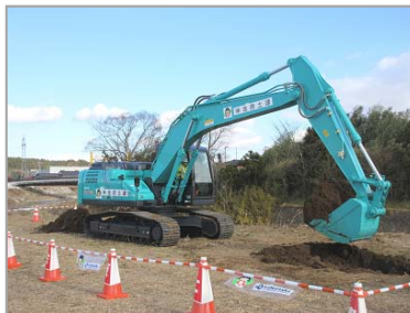
▲工事着工（河道掘削）
