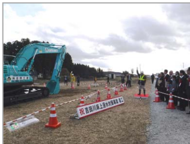
▲内田出張所長による工事着工号令
