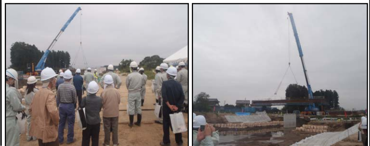
(550tクレーンによる上部工架設)
