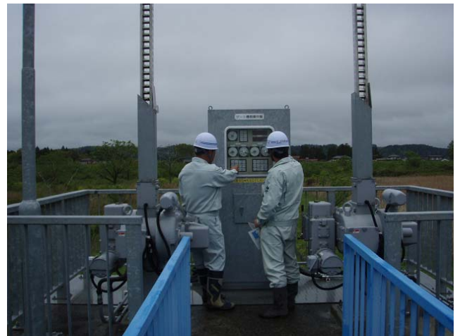
点検の様子（鷹ノ巣第3排水樋管：大和町）
