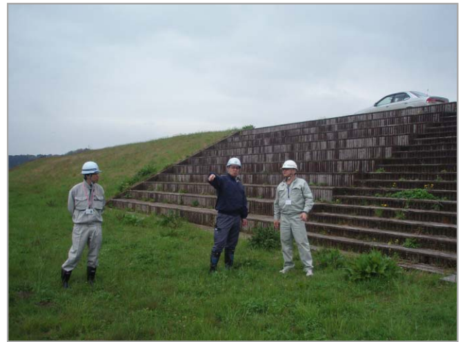
親水施設の確認状況（東松島市 鳴瀬大橋付近）
