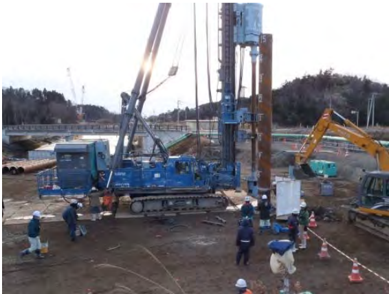
←杭打ち施工の様子
