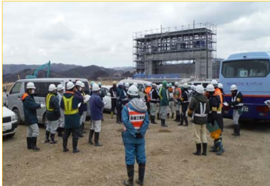
水門の工事現場をパトロールしている状況
