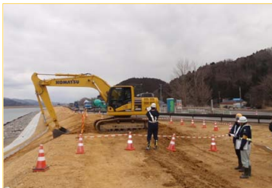
築堤工事では、重機作業などを点検しました
