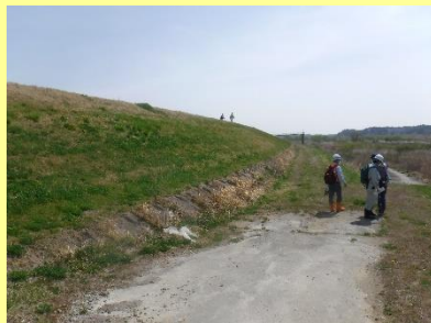
▲堤防に亀裂や陥没がないか点検します。
