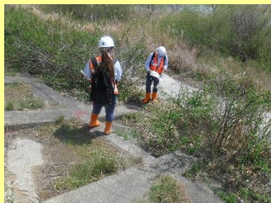
▲堤防に亀裂や陥没がないか点検します。
