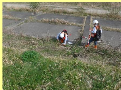
▲堤防に亀裂や陥没がないか点検します。
