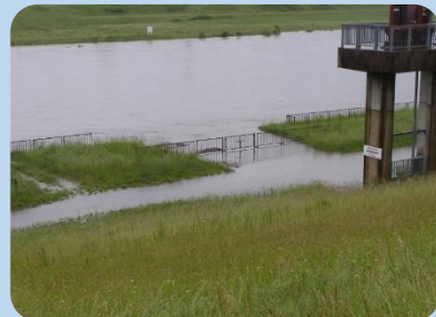
▲河川敷が浸水
