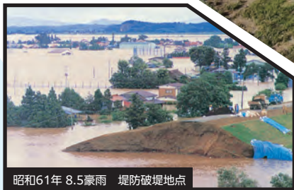
昭和61年 8.5豪雨 堤防破壊地点
