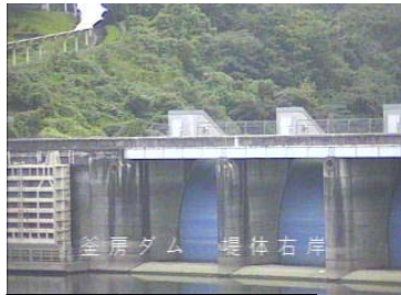
洪水前の釜房湖の状況
