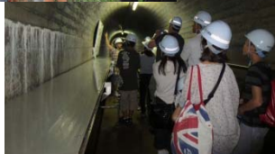
▲ダム堤体内見学
