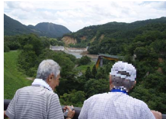
落橋した祭時大橋と、 その向こうに見える槻木平砂防堰堤
