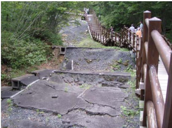
祭時大橋見学通路
