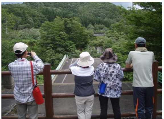
落橋した祭時大橋を見学
