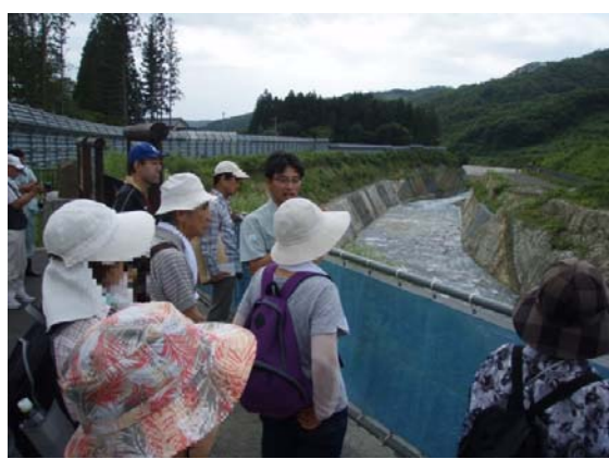
市野々原地区の磐井川付替水路の説明
