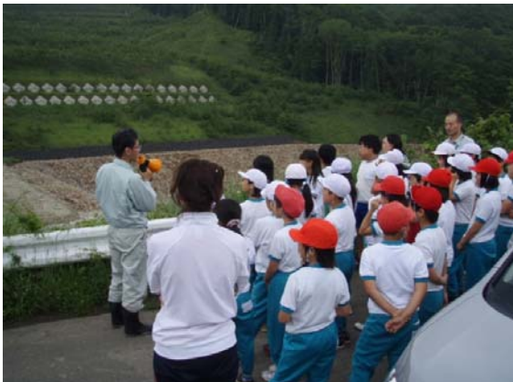
昨年工事完了した「市野々原砂防堰堤」
