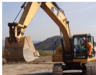
建設機械運転体験
