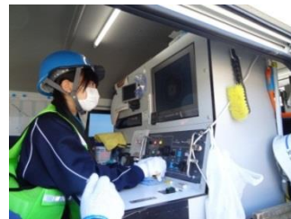
下水道調査カメラ操作体験
