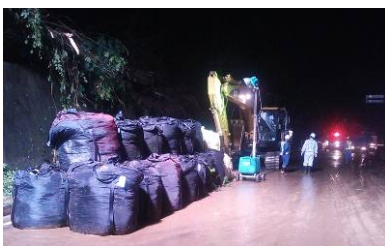
▲夜通し行われた復旧作業 (8月9日 雫石町内)
