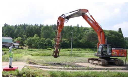
▲工事着工の指示
