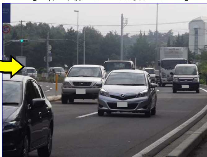
【全線4車線となった石鳥谷バイパス】
