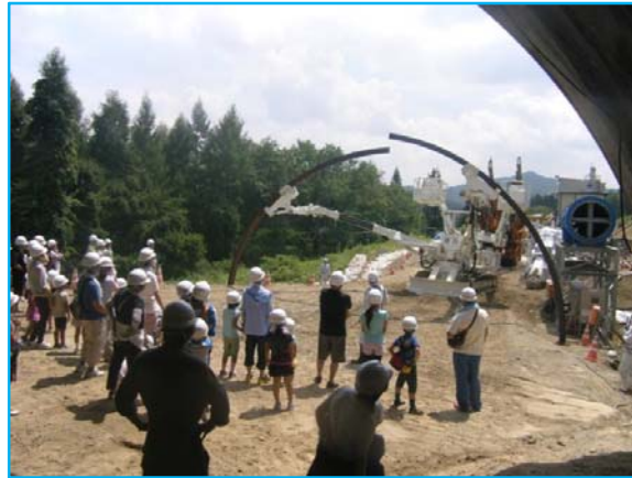
鍋倉トンネル(支保工)
