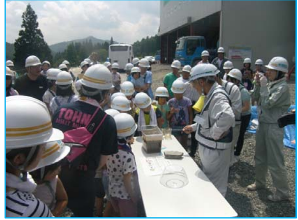
鍋倉トンネル(濁水処理)
