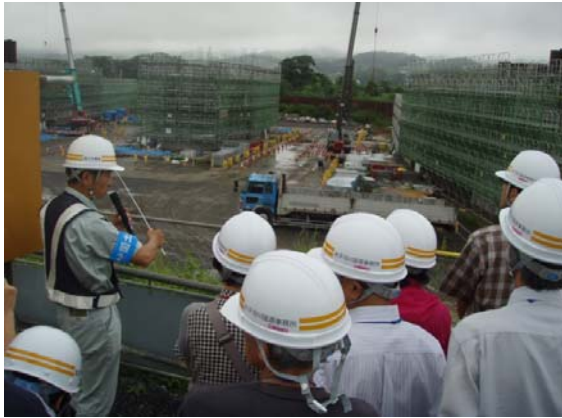
大林水門の工事概要説明
