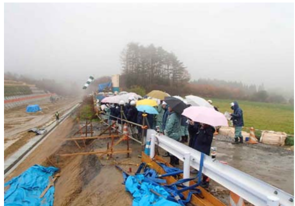
下綾織法面工
