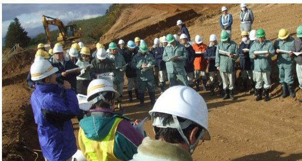
〈手代森トンネル（盛岡側）での説明〉
