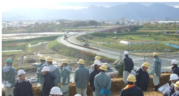
〈手代森トンネル（盛岡側）から都南大橋を望む〉
