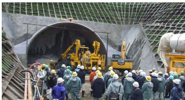
〈手代森トンネル（宮古側）坑口〉
