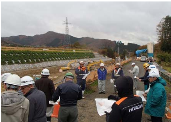
下綾織法面工
