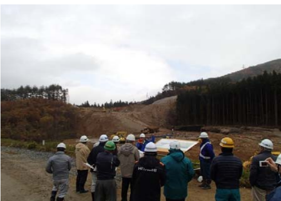
遠野IC（本線部・釜石方面を望む）
