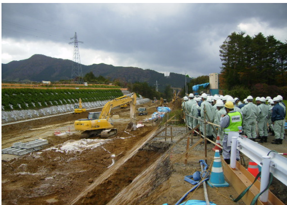
下綾織法面工
