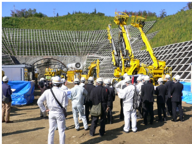
手代森トンネル宮古市側坑口
