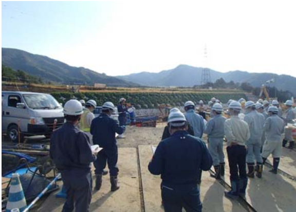
下綾織法面工
