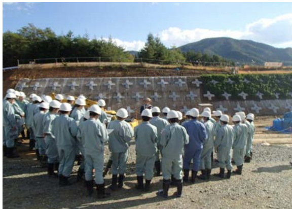
下綾織法面工
