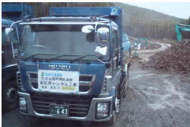
区界道路現場
