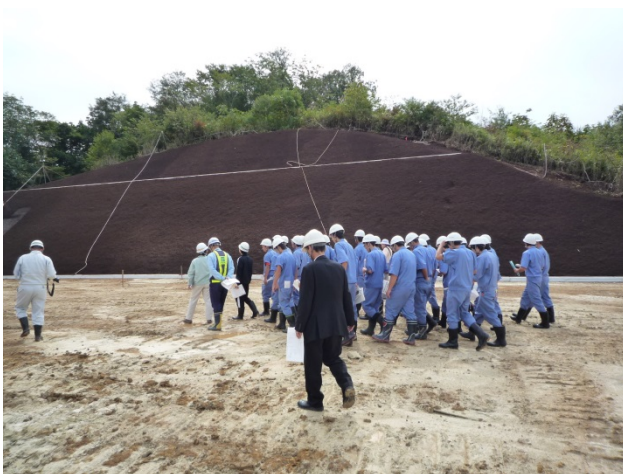
法面保護工の施工状況を見学
