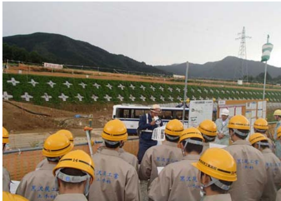
下綾織法面工
