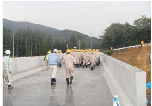
遠野地区こ道橋（向新田こ道橋）
