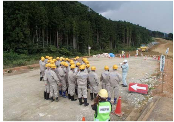
下綾織盛土工
