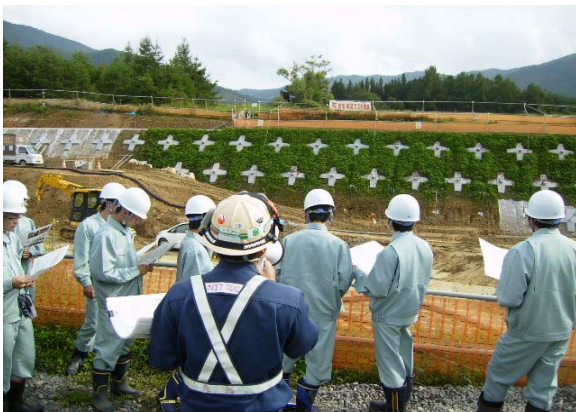
下綾織法面工
