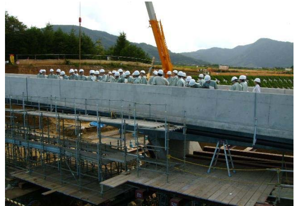
遠野地区こ道橋（向新田こ道橋）
