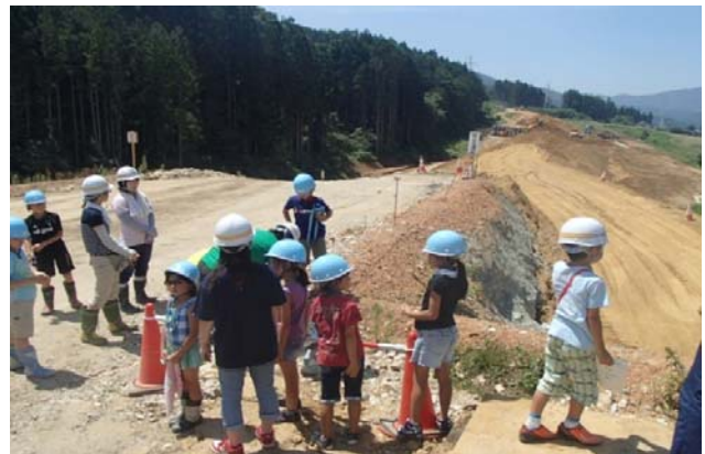
下綾織盛土工
