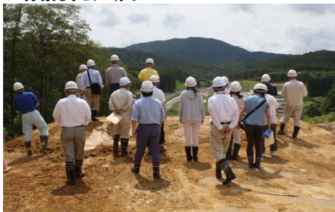
宮守IC（掘削工）
