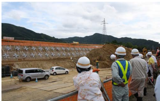
下綾織法面工
