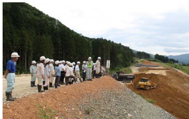
下綾織盛土工
