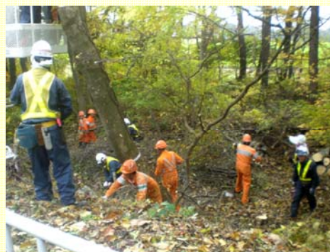
伐採にあたり周辺のツタなど雑木を取り払い整地します。
