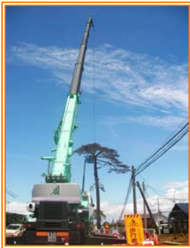
伐採1日目 アーム30mの50t吊クレーンなど 伐採のための重機が現場に 到着しました
