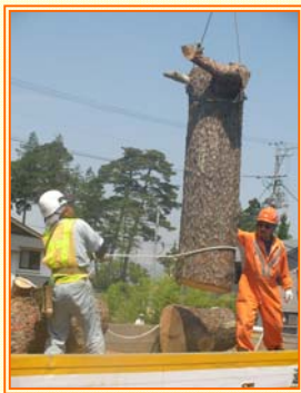
約15mのアカマツを1~4m単位で 切っていく荷台に載せます 重量は全部で3.3tありました
