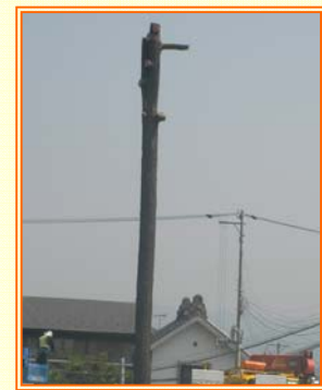
枝を全て切って幹だけになりました 伐採作業1日目はここで終了です
