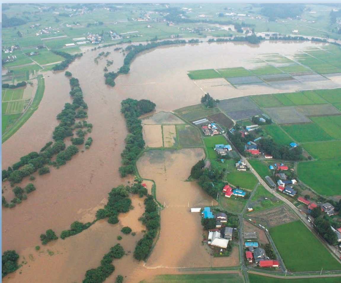
北上川 無堤部からの浸水状況（紫波町甘木地区）
