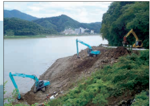
流木撤去状況
