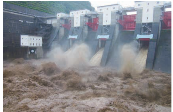
御所ダムによる防災操作の状況
