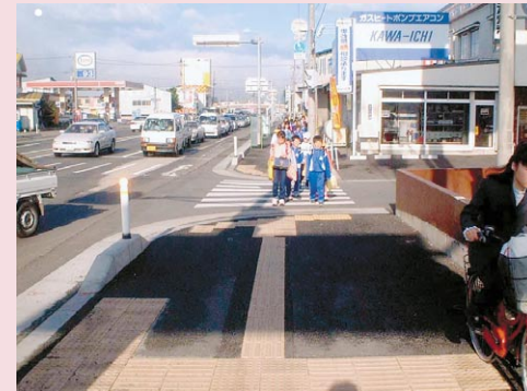
国道4号 盛岡市上田の段差、障害物をなくした後の歩道
