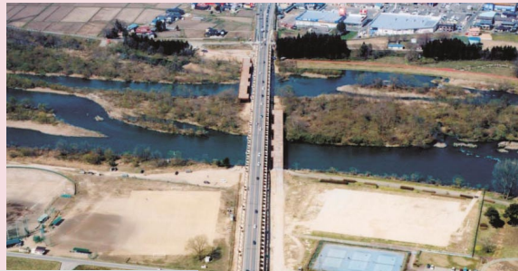
国道4号 北上拡幅の「和賀大橋」の全景
