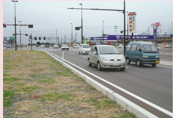
国道46号 盛岡市本宮の「盛岡西バイパス」の状況
