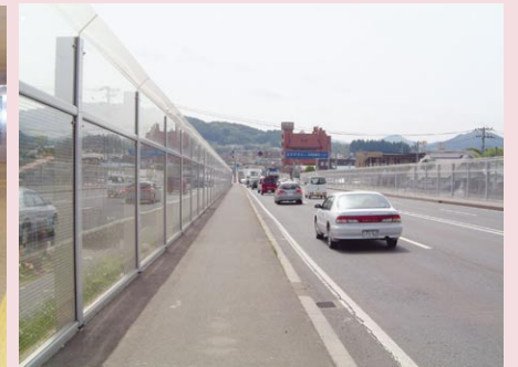
国道4号 盛岡市加賀野に設置されている透明な遮音壁
