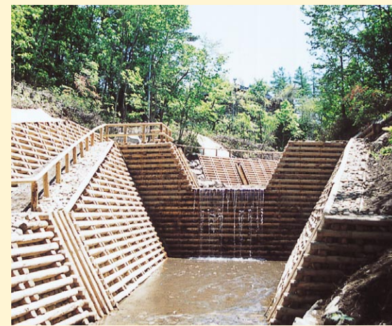
西根町の焼走りに、木で造られた砂防えん堤
