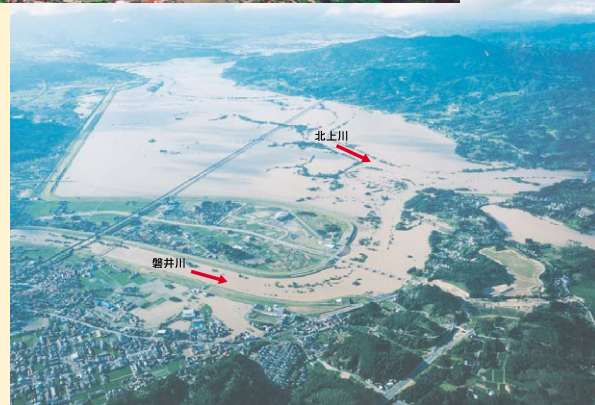
堤防ができた後の洪水時の様子 堤内への氾濫が防止され、洪水は遊水地内に治まっています。
