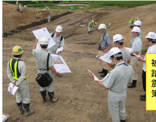
堤防被災の原因調査状況
