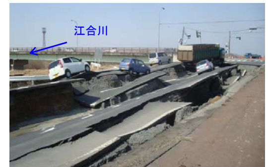
地震による堤防崩壊 (江合川右岸27.6k付近 大崎市古川淵尻地先)
