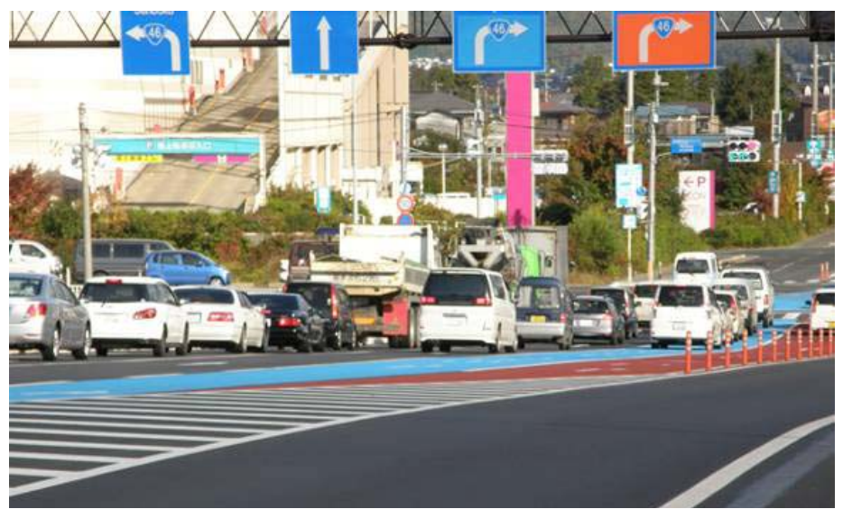
▼盛岡西バイパス北口交差点の混雑状況（仙北町方面からの流入）
